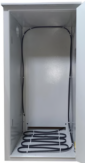
Рис. 3. Пример монтажа электрокабеля длиной 6,25 м в нижней и задней частях термобокса
